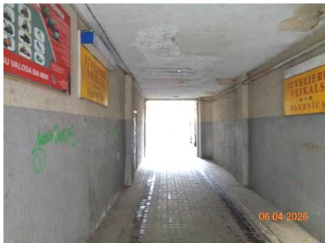
Caurbrauktuve uz iekšpagalmu
